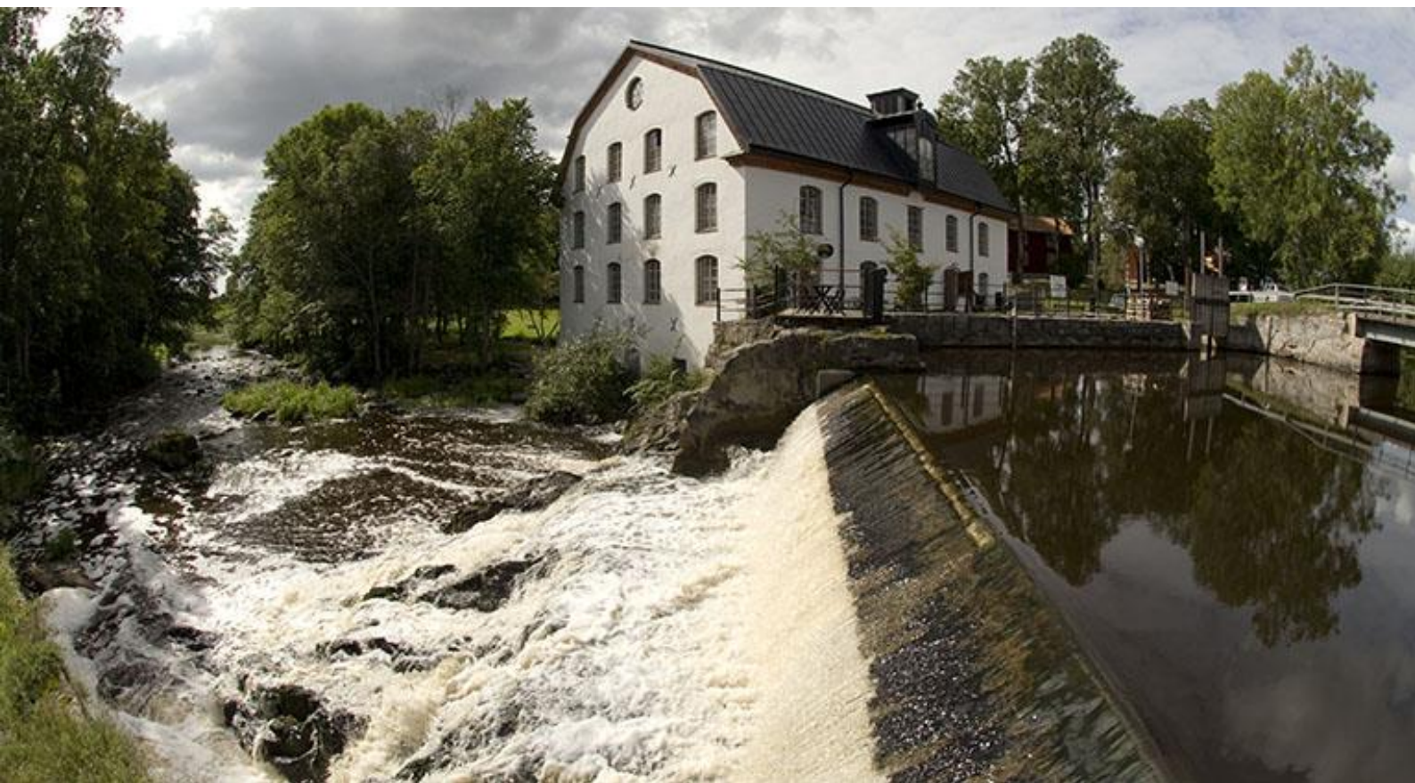
Kammarkollegiet ska föra vattnets talan i mål om vattenverksamhet. Foto Nicklas Wijkmark, Azote
